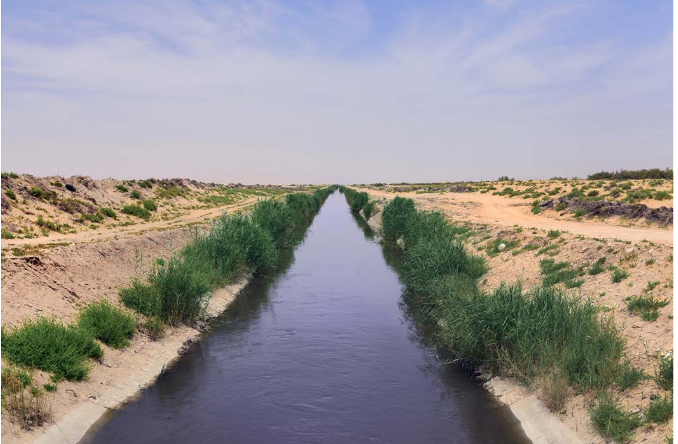
جزء قناة المياه الحديثة لمشروع الري والصرف بالأحساء
