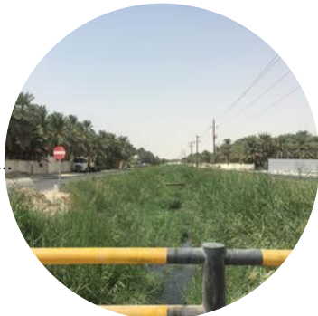
قناة إمدادات المياه
