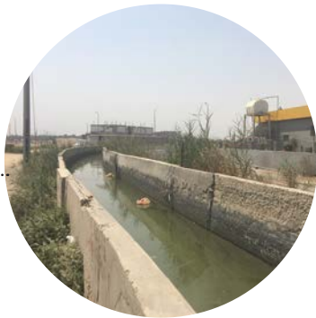
قناة تصريف المياه
