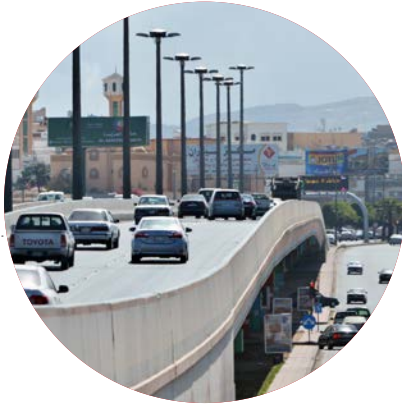
البنية التحتية للطرق بأبها
